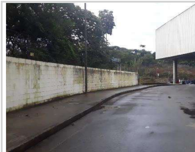
MUROS DE FECHAMENTOS DO TERRENO
