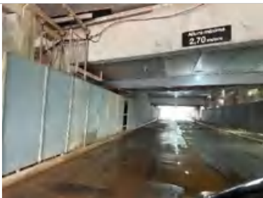
Expansão – em obra
