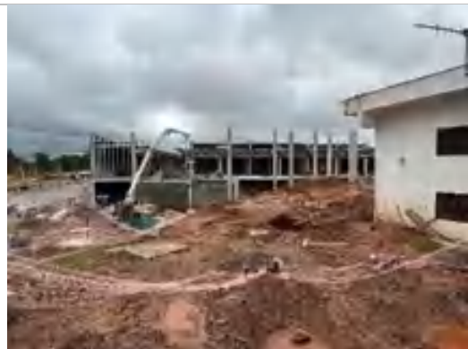
Expansão – em obra
