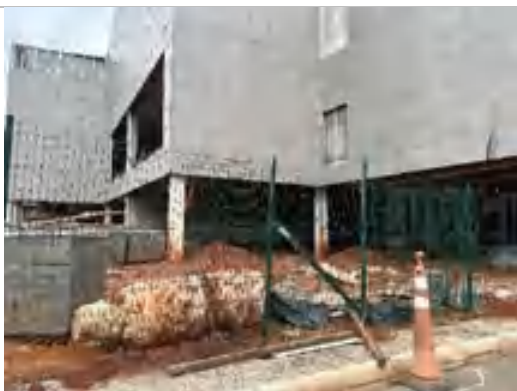
Expansão – em obra
