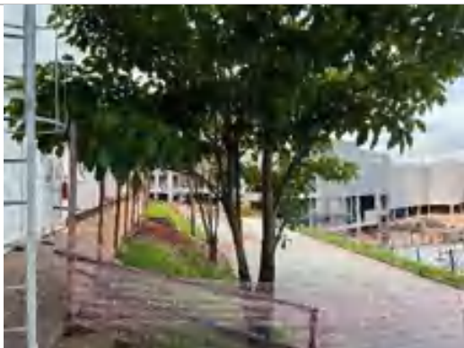
Expansão – em obra
