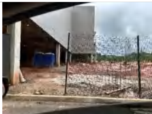
Expansão – em obra
