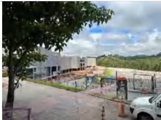
Expansão – em obra
