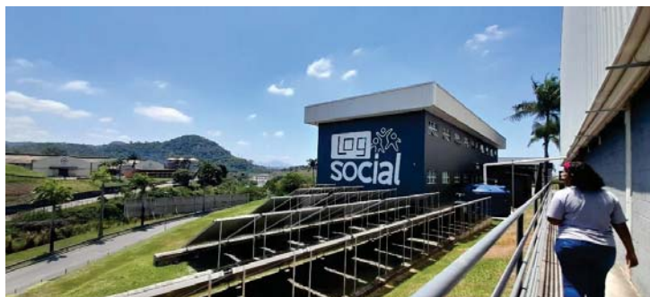
Área de comum do condomínio – área técnica
