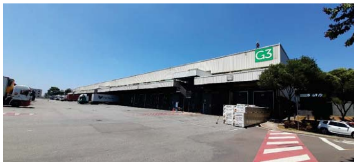
Vista externa do galpão
