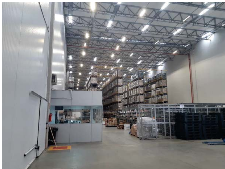
Vista interna do imóvel
