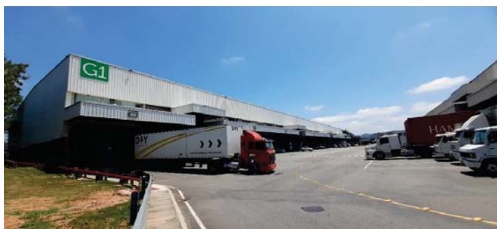
Vista externa do galpão
