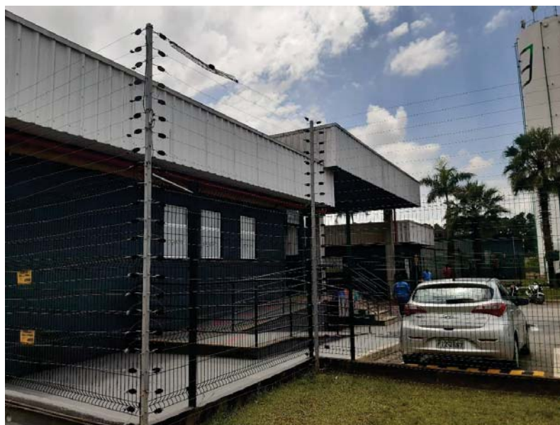
Portaria de acesso
