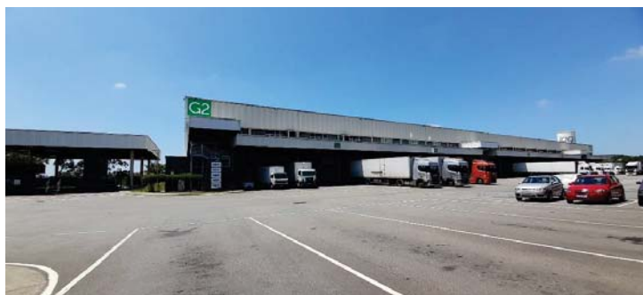
Vista externa do galpão
